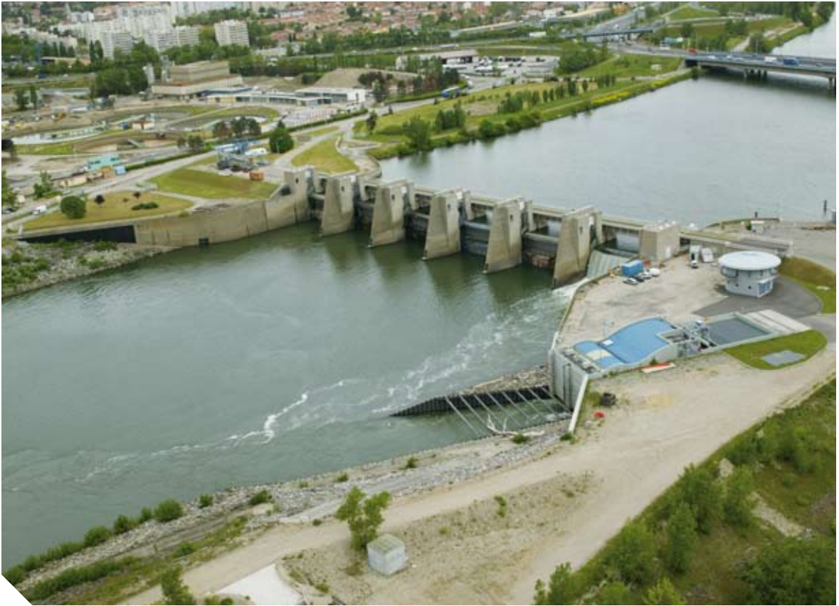
Une micro-centrale turbine le surcroît de débit accordé au Vieux-Rhône (© Photothèque CNR).
